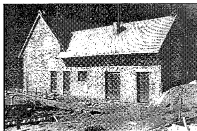
Budynek oczyszczalni „Pustki” - Koniaków
