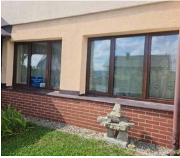
Wymienione okna w budynku I fot. arch. SP1 w Jaworzynce
