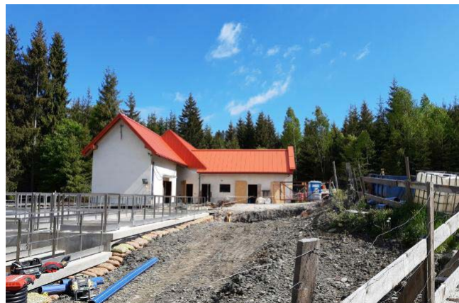
Budynek oczyszczalni ścieków Pustki w Koniakowie | fot. arch. UG Istebna
