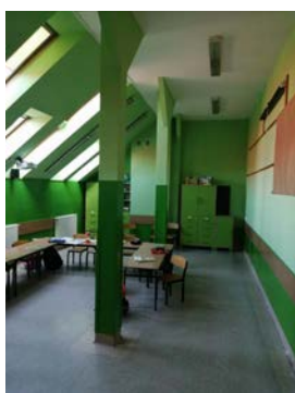
Malowanie klas, naprawa okien dachowych | fot. arch. SP2 w Istebnej
