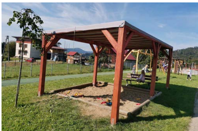
Wyremontowana wiata nad piaskownicą przy ZSP Istebna | fot. arch. szkoły
