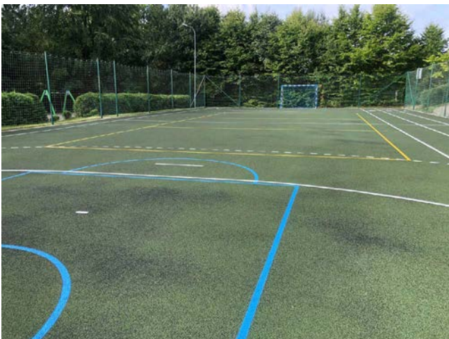
Naprawiona nawierzchnia boiska I fot. arch. SP2 w Jaworzynce
