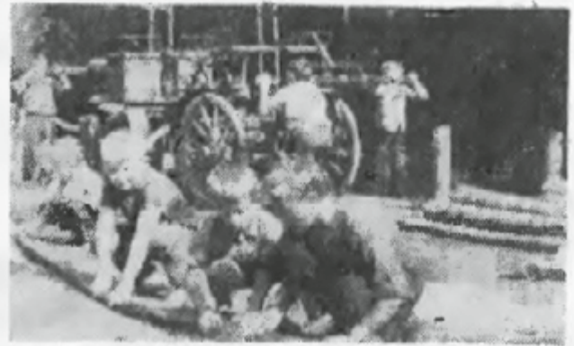
Przy budowie mostka pracowały również dzieci i młodzież — obsługiwały one starą strażacką pompę, dostarczającą wodę do betoniarki
