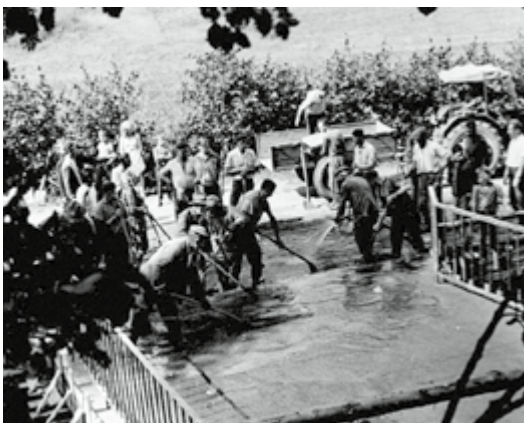
> Prace przy budowie mostu
